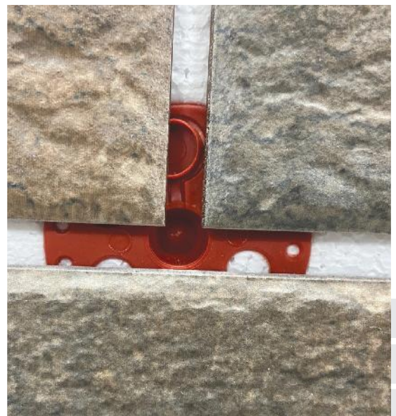
Малюнок 2. Закладний елемент у клінкерній термопанелі
