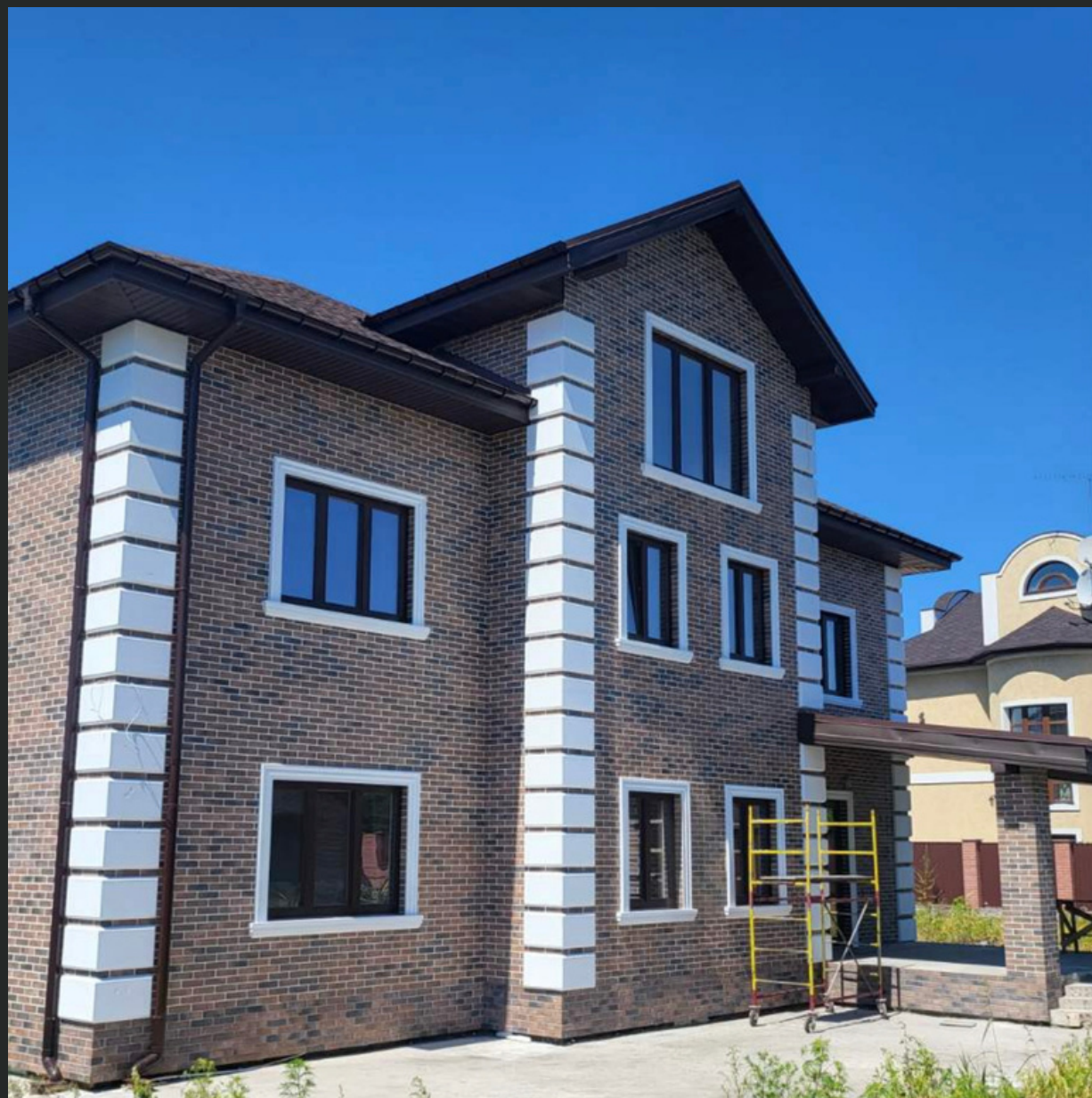
ПРИВАТНІ БУДИНКИ тепло та красиво
